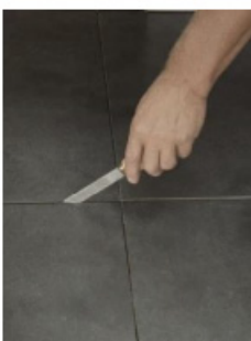
1. Limpiar las juntas de materiales no deseados.
