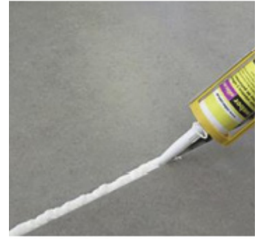
I Junta estructural con material elástico sup. máx. 25 m2
